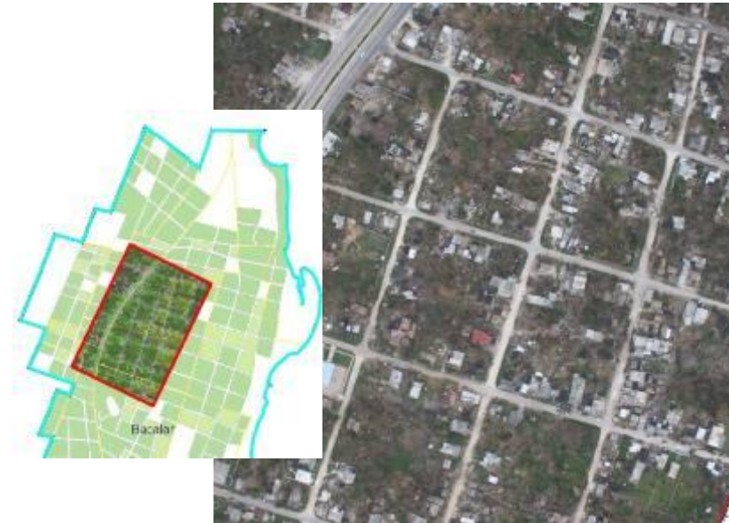
Daños en Vivienda, Dean 2(008 )
