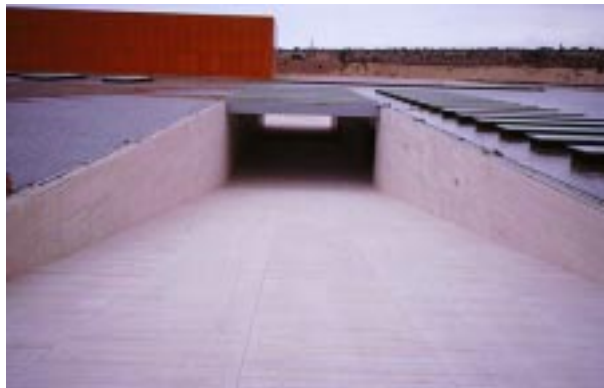
MUA. Rampa de acceso.
