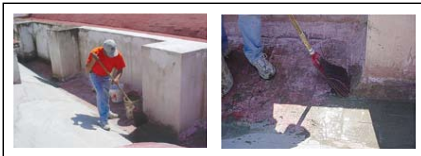
Figura 36. Aplicación de color óxido, sellador y cemento.
